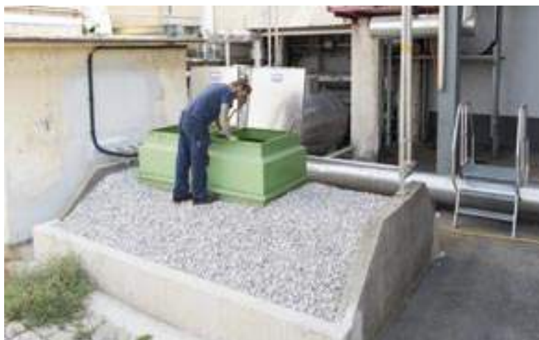
Inspektion eines Domschachts (unterirdischer Lösungsmitteltank) durch Harald Stassler
