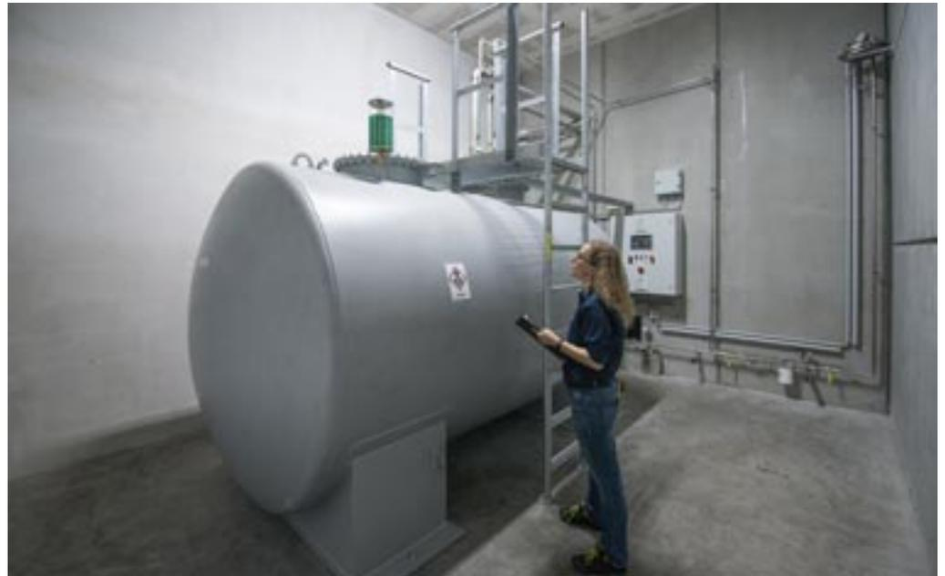
Betriebsmitteltank mit Doppelmantel und Leckanzeiger in separatem Brandabschnitt untergebracht
