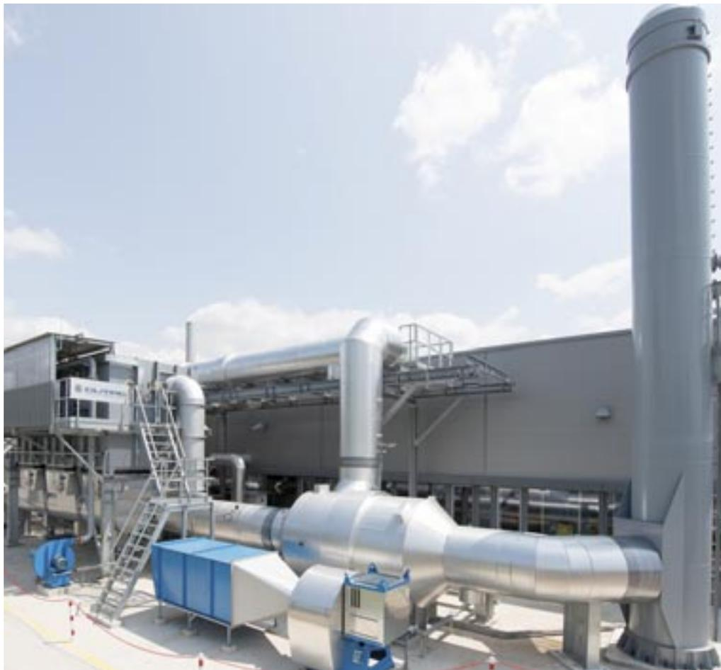
So sieht Luftreinhaltung aus – die neue RTO zur Abluftreinigung.
