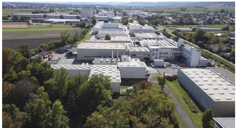
Blick auf die KLINGER Dichtungstechnik
